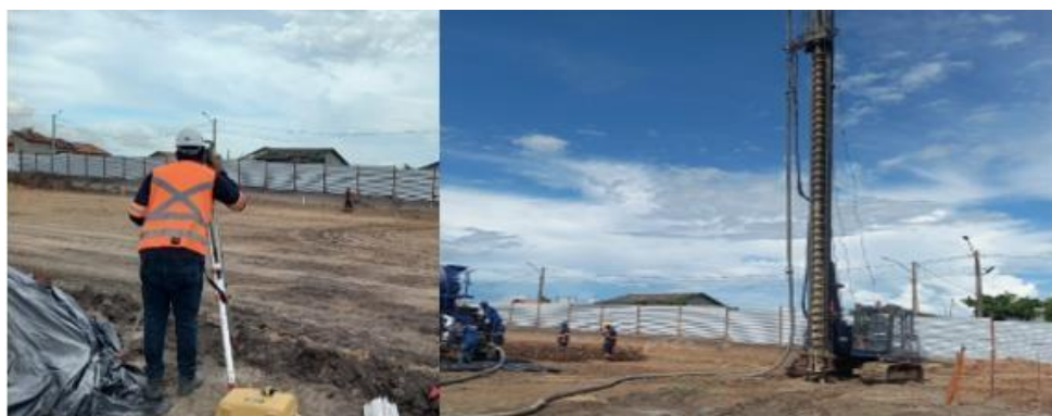
Figura 10: Locação da estaca e perfuração da estaca.
