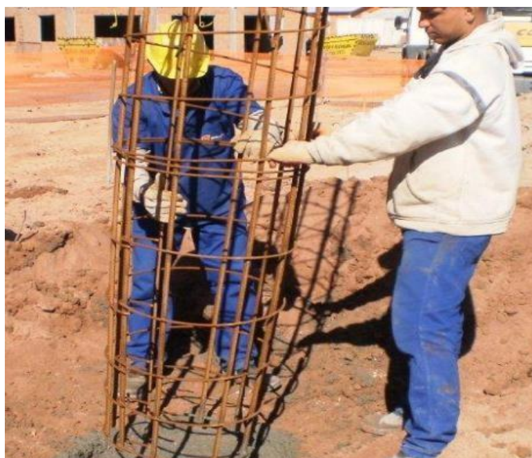
Figura 5: Posicionamento de armação
