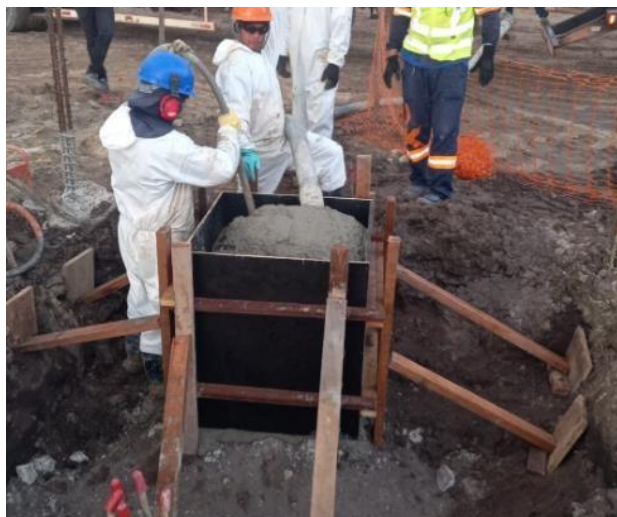
Figura 13: Concretagem do bloco de reação.
