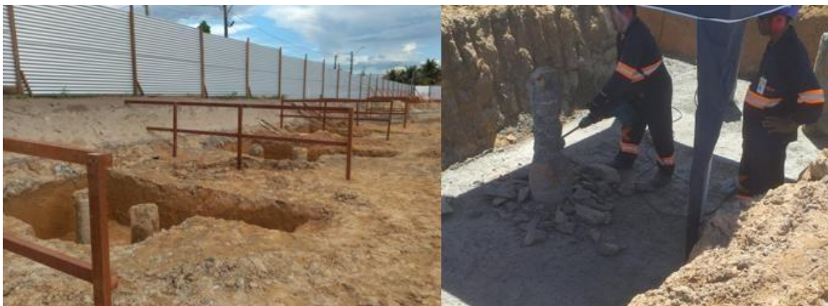
Figura 12: Escavação do bloco e arrasamento da estaca.
