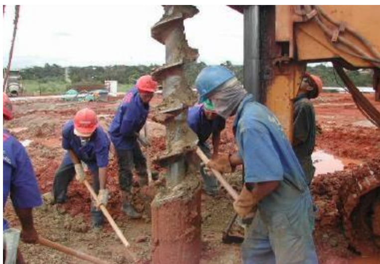
Figura 4: Limpeza do trado e concretagem
