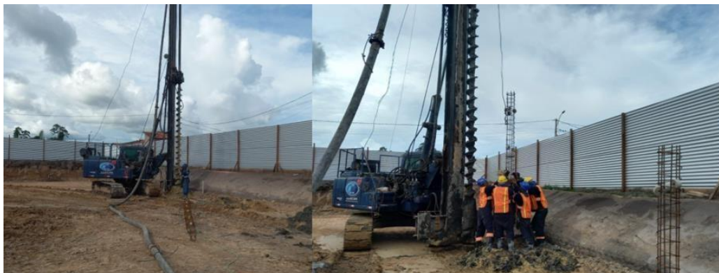
Figura 11: Concretagem e inserção da armadura.
