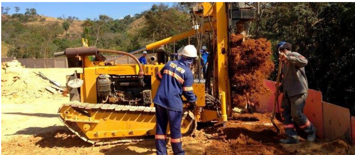
Figura 3: Perfuração de estaca com trado contínuo
