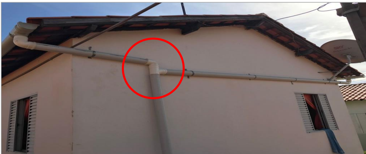
Figura 12 - Layout dos condutores verticais e horizontais.
