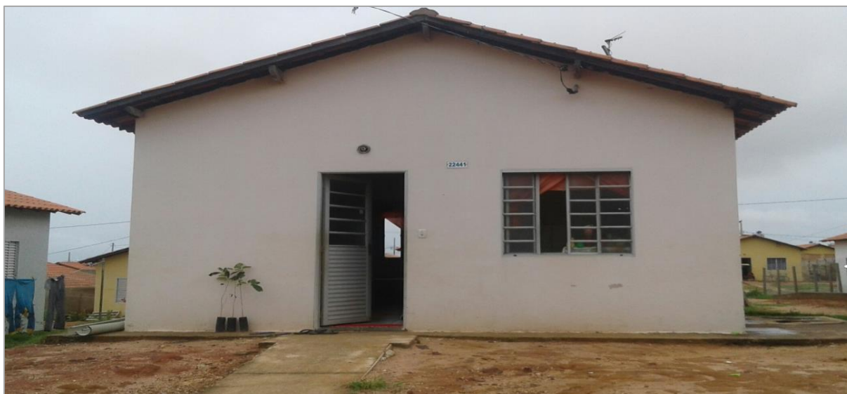
Figura 2 - Residência que recebeu o sistema de águas pluviais
