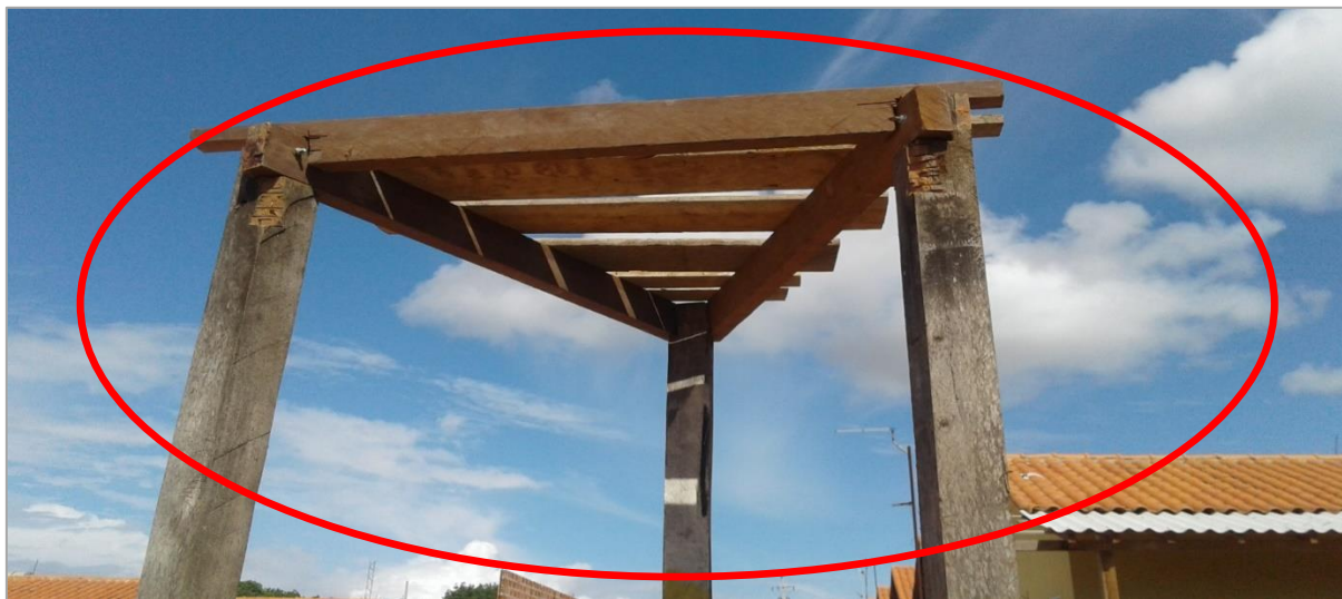
Figura 10 – Suporte do reservatório superior
