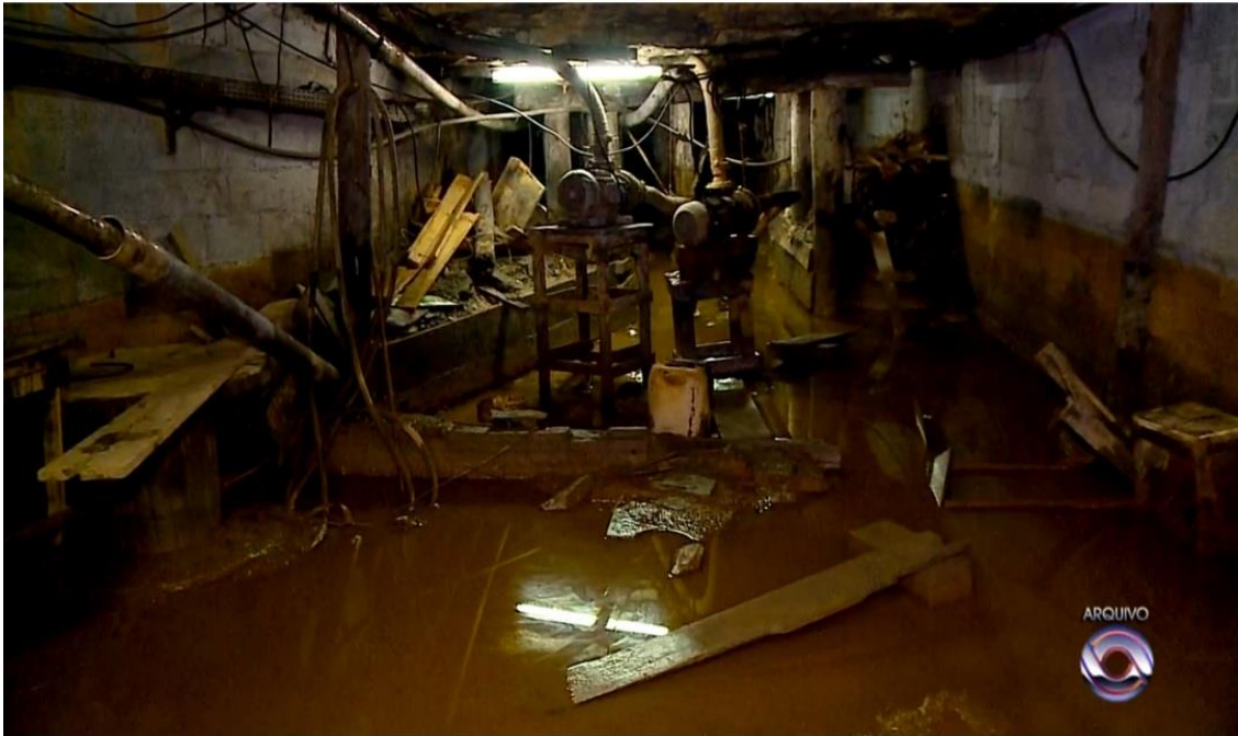
Figura 7 - Mina do Verdinho, galeria com equipamentos abandonados.
