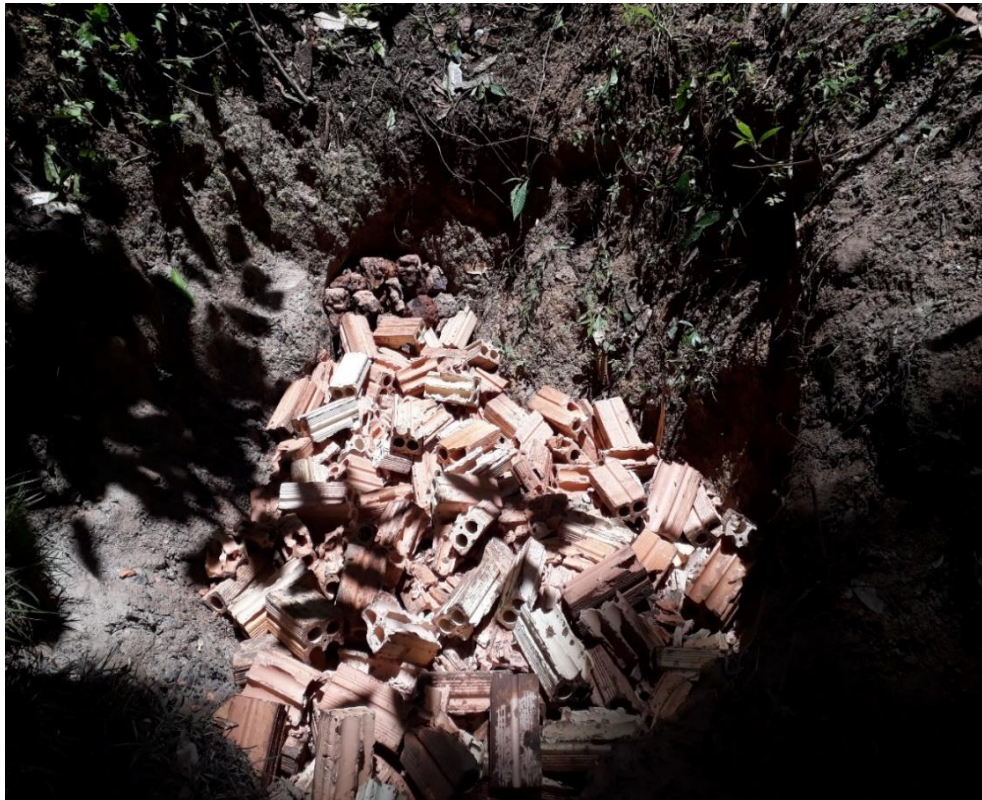
Figura 17 – Colocação de pedaços de tijolos Fonte: O autor, 2018
