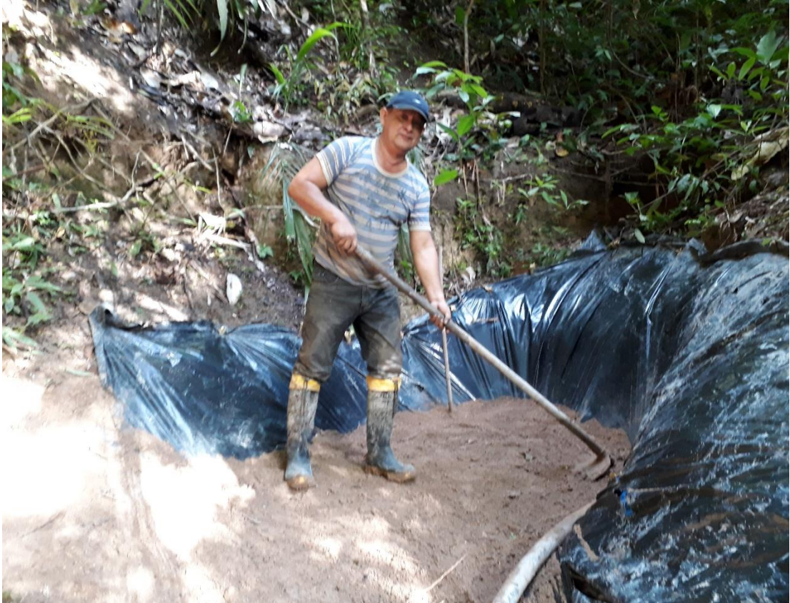
Figura 20 – Cobertura de toda estrutura com terra. Fonte: O autor, 2018
