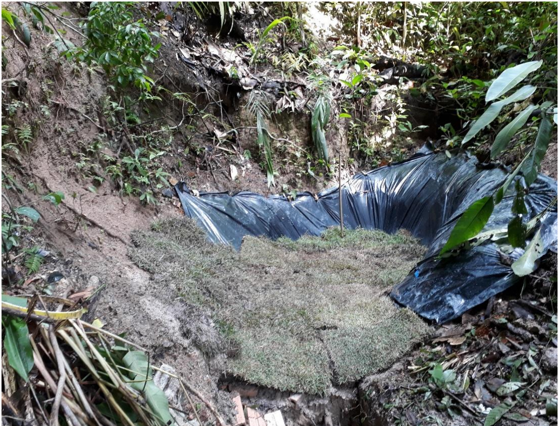
Figura 21 – Cobertura de toda estrutura com terra Fonte: O autor, 2018
