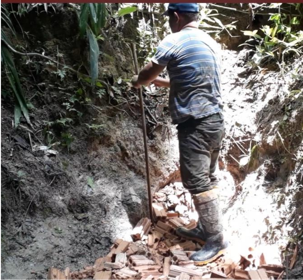
Figura 18 – Colocação de tubo para desinfecção Fonte: O autor, 2018
