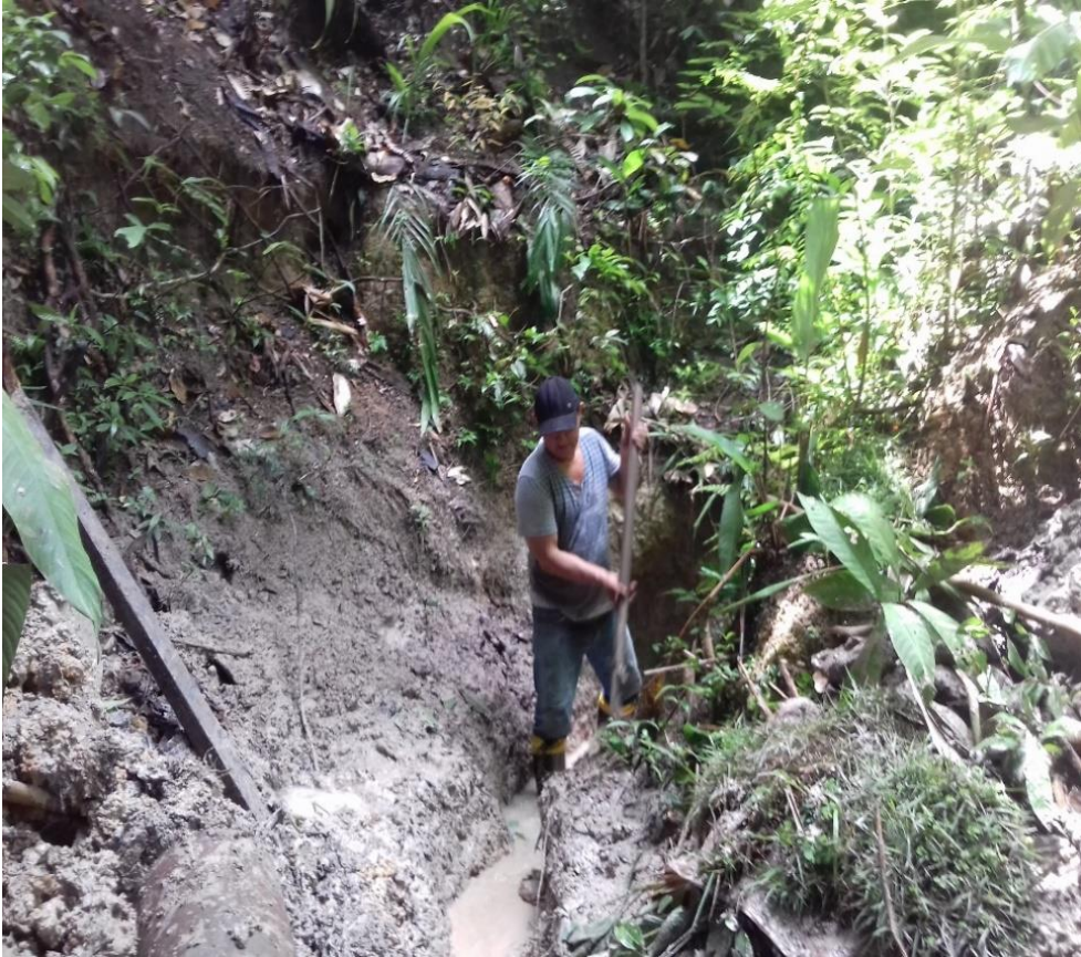
Figura 13– Abertura da vala para colocação do tubo de concreto Fonte: O autor, 2018
