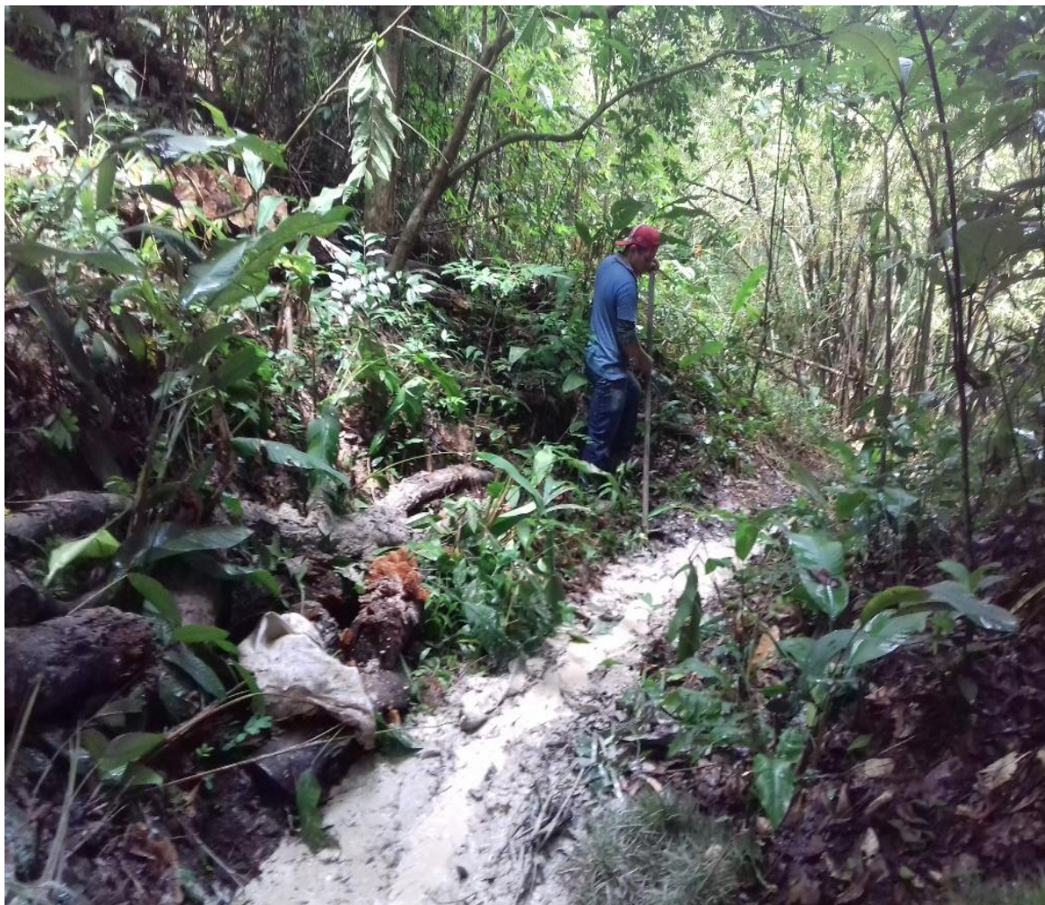
Figura 12 – Limpeza do local de captação de água Fonte; O autor, 2018
