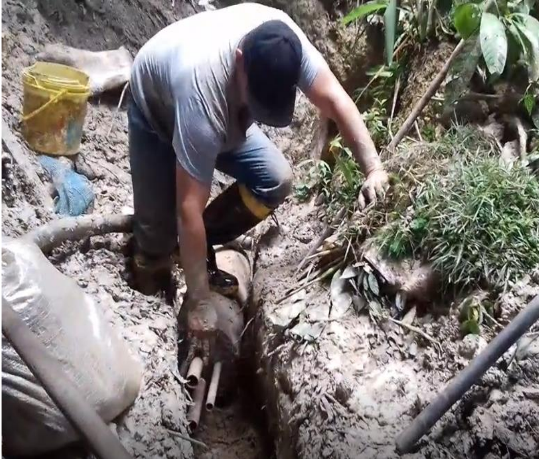
Figura 15 – Assentamento do tubo
