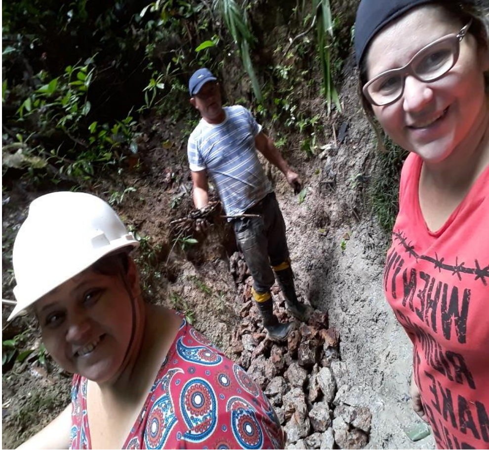
Figura 16 – Colocação manual das pedras Fonte: O autor, 2018
