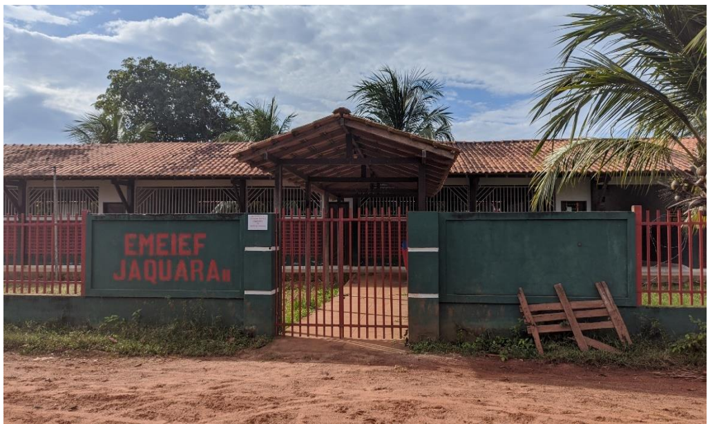
Figura 4- Vista frontal da Escola Jaquara II
