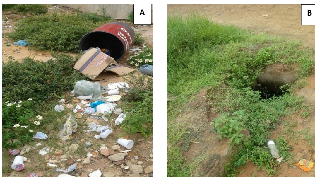
Figura 30 – (A) Lixo despejado em via pública podendo ocasionar entupimento nos dispositivos de drenagem; e (B) Sistema de drenagem urbana comprometido pelo mato da cidade de Óbidos, Pará, Brasil. (Fonte: Próprio autor).
