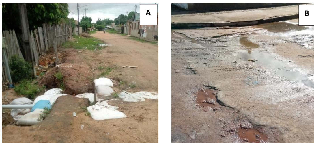
Figura 29 – (A) Ausência de infraestrutura na rua Antônio Fernandes no bairro da cidade nova; e (B) Asfalto deteriorado na rua Antônio Brito de Sousa, bairro de Santa Terezinha na cidade de Óbidos, Pará, Brasil. (Fonte: Próprio autor).
