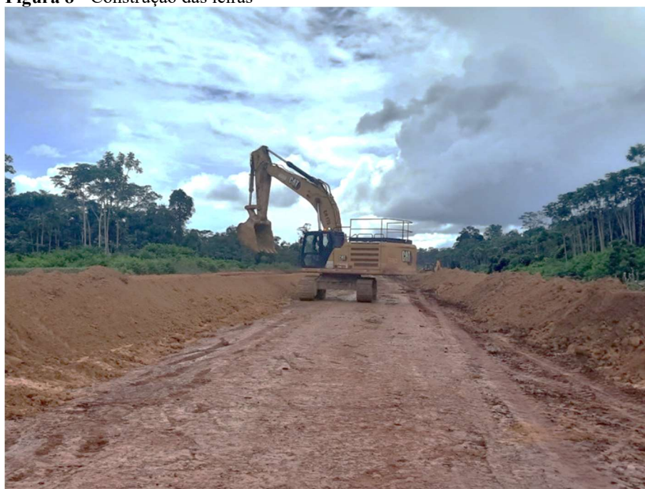
Figura 8 - Construção das leiras
