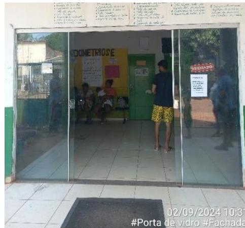
Figura 30 — Porta de entrada, de vidro
