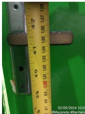
Figura 33 — Altura das maçanetas
