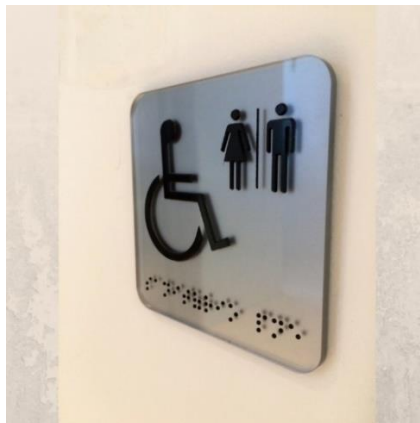
Figura 11 — Combinação entre Sinalização tátil e visual
