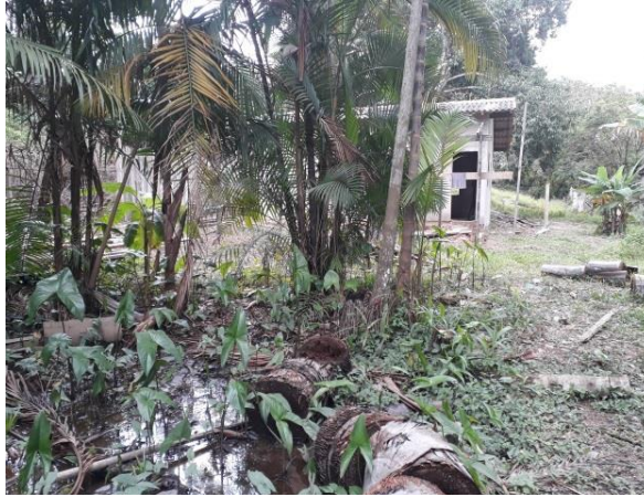
Figura 40: construção de casa as margens do leito
