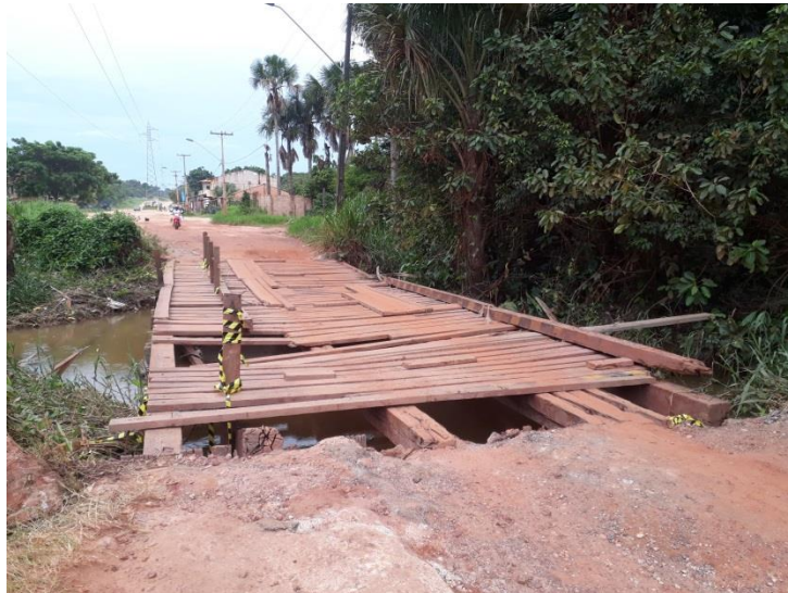
Figura 48: ponte de acesso aos bairros adjacentes
