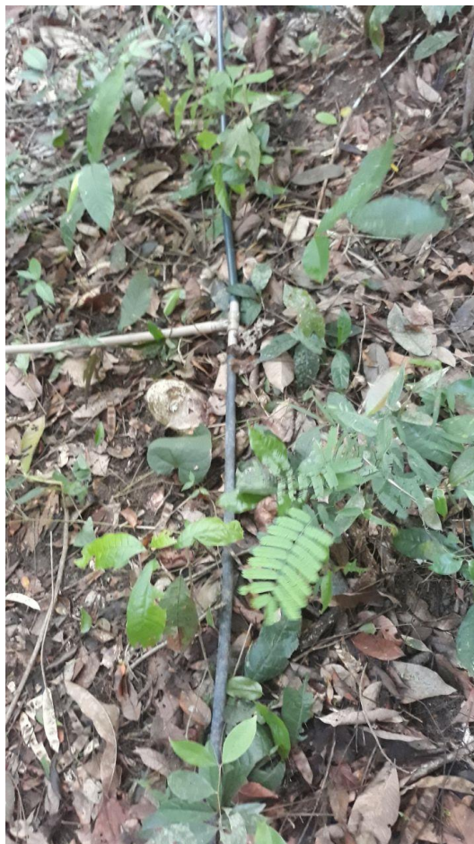
Figura 11: Canalização da água da nascente para as residências
