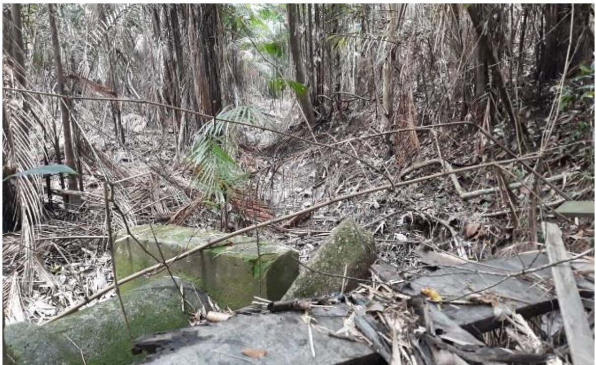
Figura 12 Estruturas da antiga estrada de acesso
