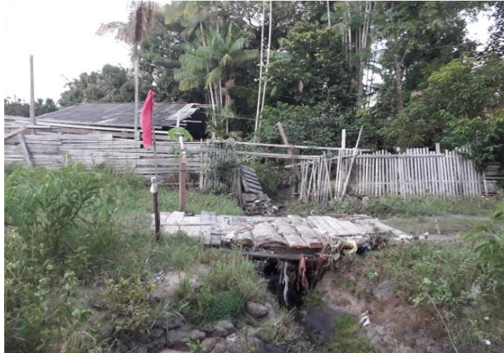
Figura 31: estrutura rudimentar de ponte
