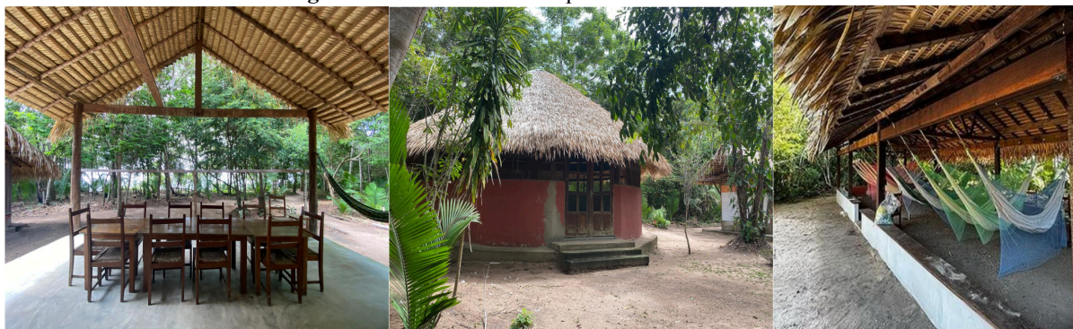
Figura 21 - Estrutura da Hospedaria Paraíso do Anã.
