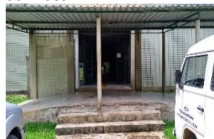
Fotos 17 e 18– Entrada e escada do Bloco 1
