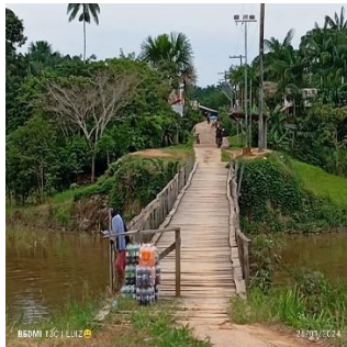
Foto 6 – Ponte de Filadélfia
