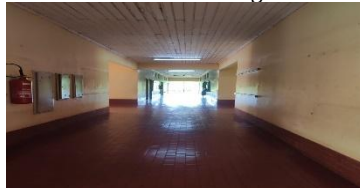
Fonte 16 – Corredor Antigo
