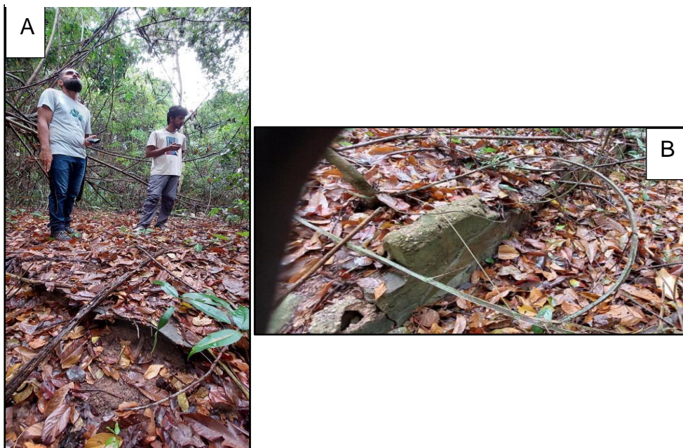
Figura 39 - A: Piso da casa da Catarina. B: Bloco de concreto.
