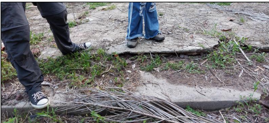
Figura 43 - Piso da antiga igreja
