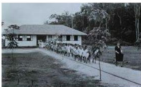
Figura 12: Escola Henry Ford (Desativada) Figura 13: Escola Santo Antônio ( Prédio desativado).
