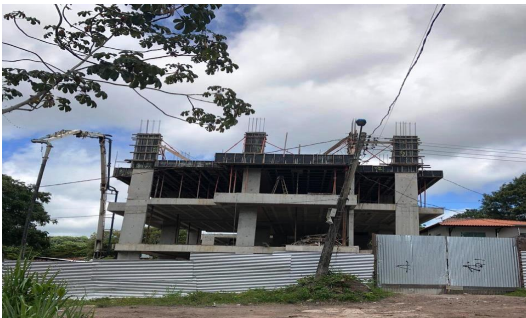
Figura 14 - Construção do Condomínio Chão de Estrelas
