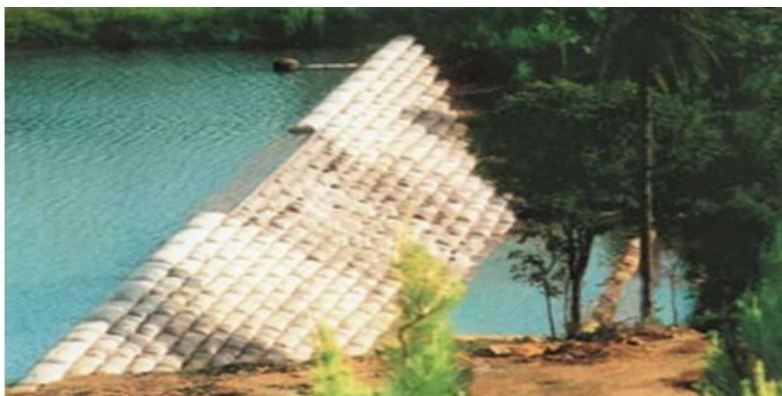
Figura 12 - Muros de sacos de solo-cimento.
