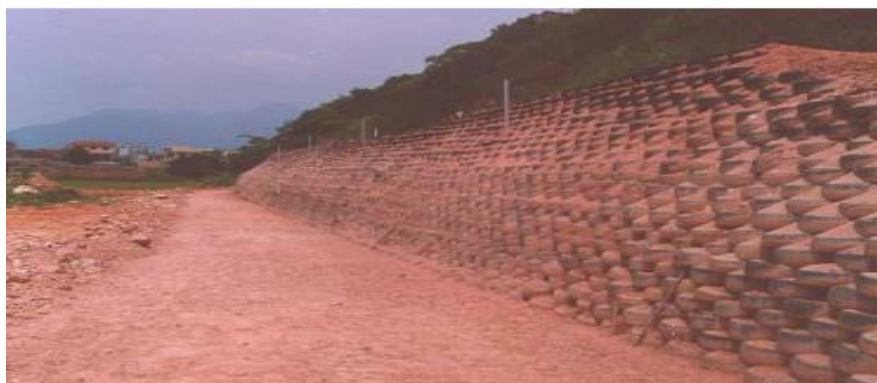
Figura 13 - Detalhe da amarração com corda de polipropileno.
