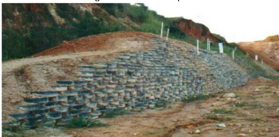
Figura 15 - Muros de pneus
