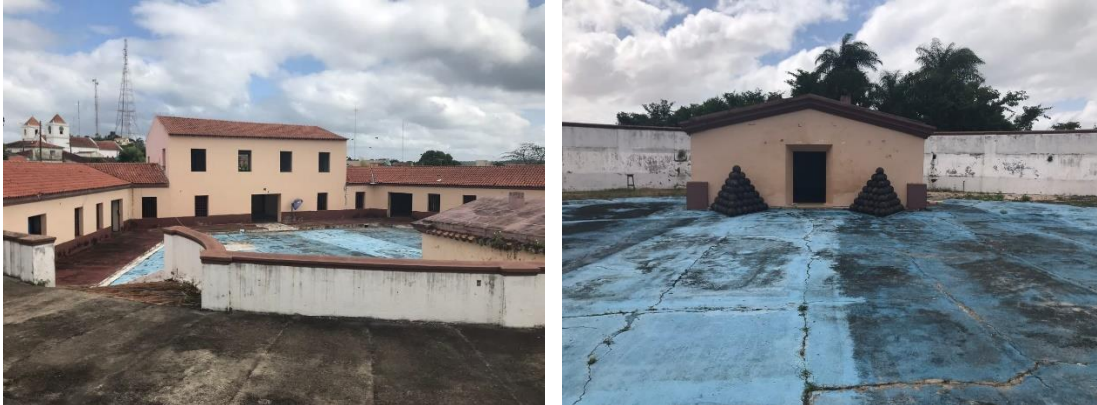
Figura 30: Estrutura na retaguarda do Forte de Óbidos
