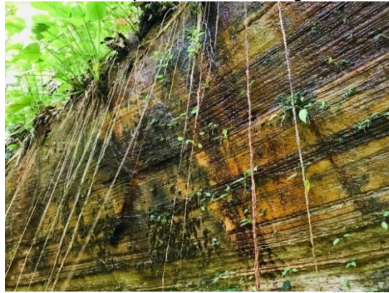
Figura 26: Paredão por onde escorre água da nascente
