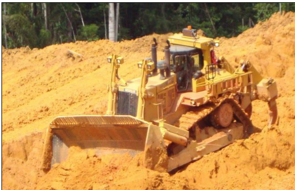
Figura 20 - Trator D11 desmontando estéril uma mina de bauxita.
