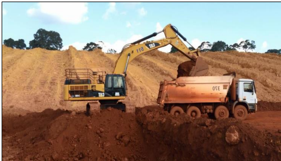
Figura 17 - Carregamento e transporte de minério feito por carregadeira e caminhão
