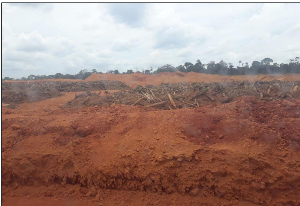
Figura 27 - Núcleos dispostos em módulo (solo orgânico, galharia e berma)
