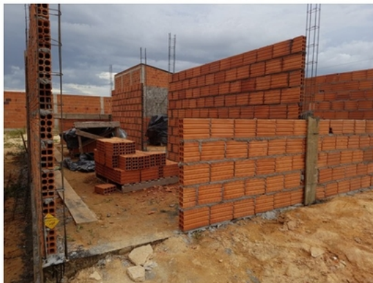
Figura 15 – Elevação da alvenaria convencional - Obra B
