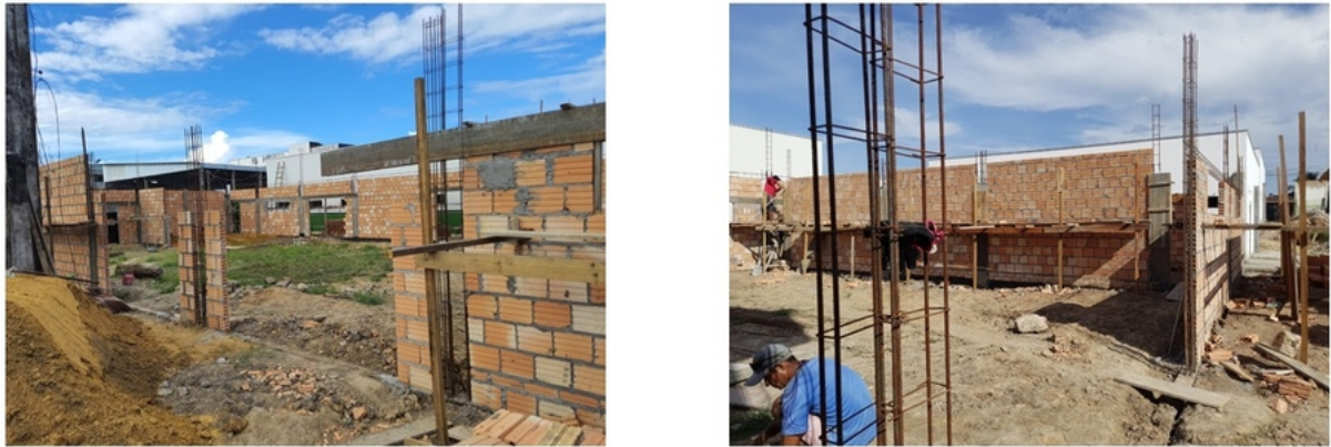
Figura 17 – Processo de construção da alvenaria - Obra C
