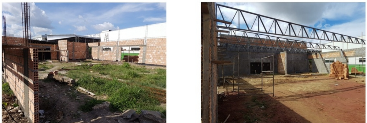
Figura 18 – Finalizando a elevação da alvenaria convencional - Obra C
