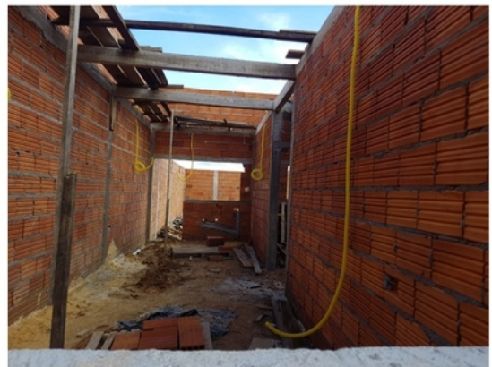
Figura 15 – Elevação da alvenaria convencional - Obra B
