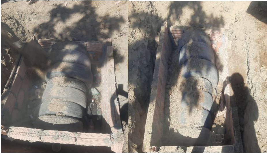
Figura 11 - Preenchimento da bacia de evapotranspiração com camadas de terra da vala escavada, cacos de tijolos e entulho presente no local.
