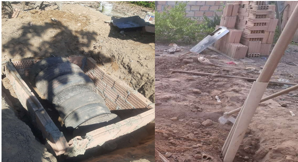
Figura 10 – Instalação da câmara anaeróbia e tubulação.
