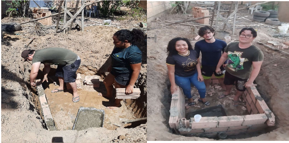
Figura 9 – Construção das paredes em alvenaria e sua conclusão.
