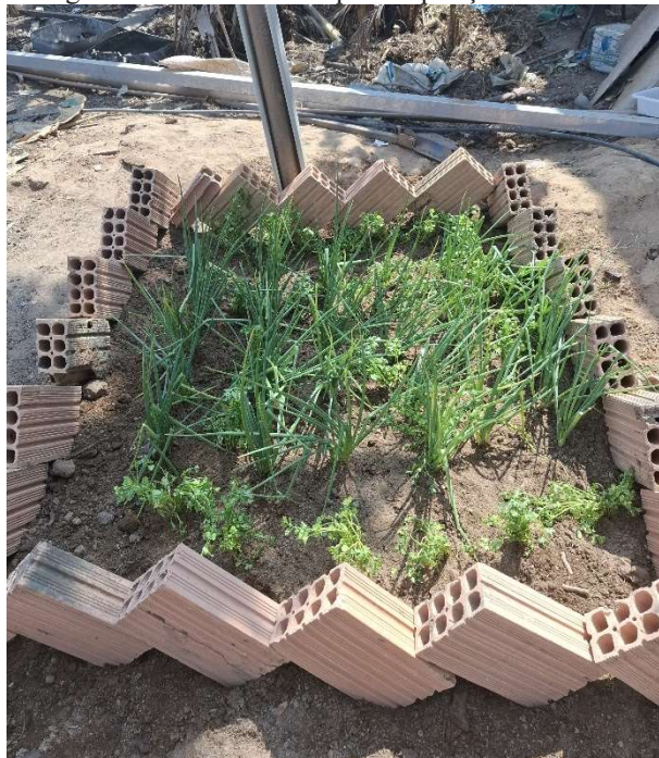
Figura 14 – Bacia de Evapotranspiração concluída.
