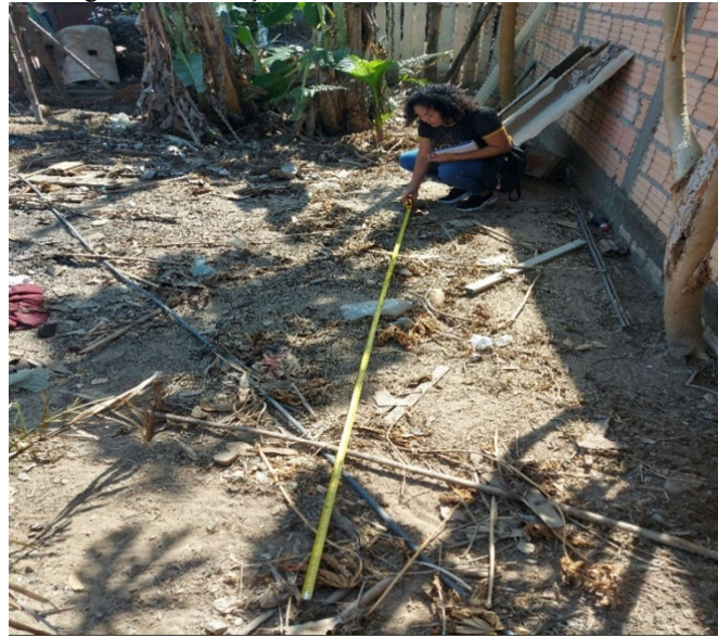
Figura 7 – Medição in loco do local a ser construído.
