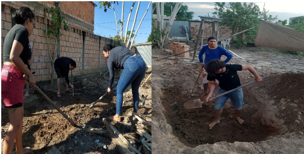
Figura 8 – Início da escavação.
