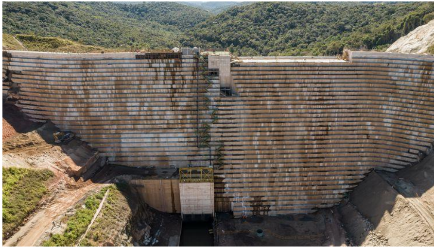
Figura 1 – Muro de Contenção
