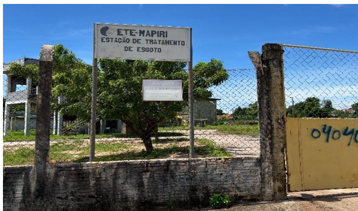
Figura 14: Entrada da ETE Mapiri
