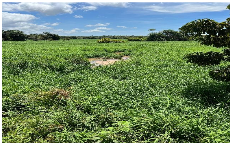
Figura 21: Esgoto que sai da ETE
