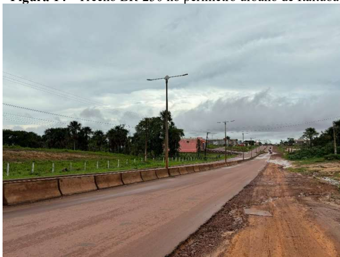
Figura 14 - Trecho BR-230 no perímetro urbano de Itaituba
