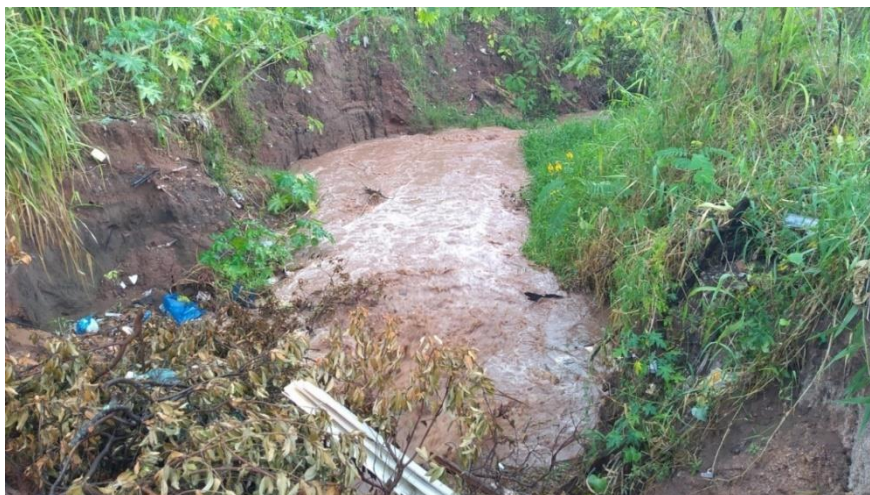
Figura 15 - Vala improvisada para o escoamento superficial às margens da Av. Castelo Branco.
