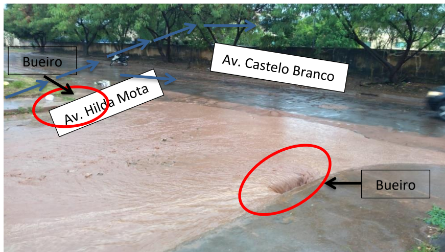
Figura 11 - Enxurrada após a chuva na Av. Hilda Mota em direção a Av. Castelo Branco.
