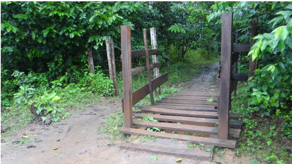
Figura 29 – Mata-burro no caminho da roça de Dinho. Essas pontes de madeira construídas pelos próprios moradores, com certa distância entre as tábuas serve para evitar o atolamento dos animais de cargas, assim como impedir que ele ultrapasse para os limites da roça a fim de
