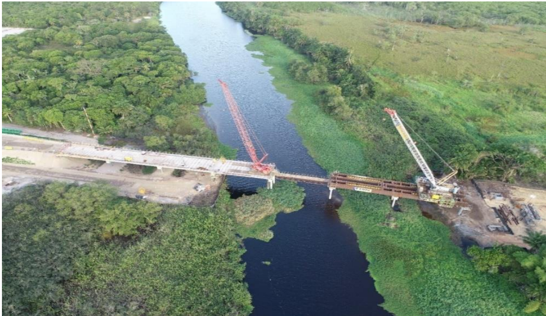
Figura 2 - Construção da Ponte sobre o Rio Almada.
