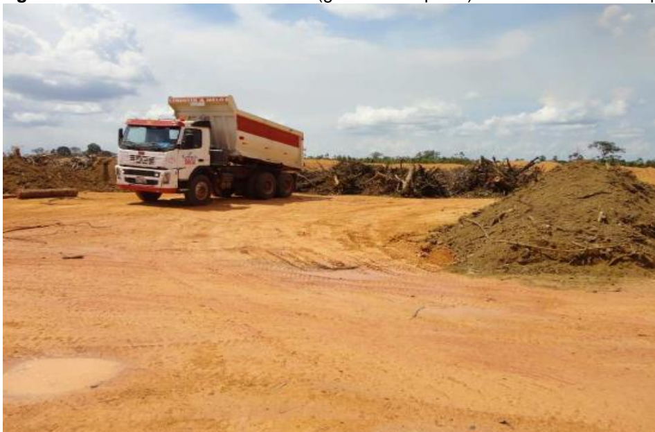
Figura 36 - Basculamento de material (galharia e top soil) nos módulos de recuperação
