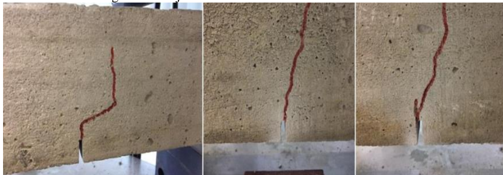
Figura 9 - Trajetória das fissuras no concreto sem fibras.
