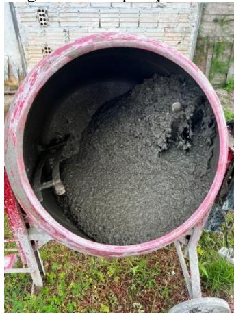
Figura 22 - Preparação do concreto com fibra manual em betoneira.
