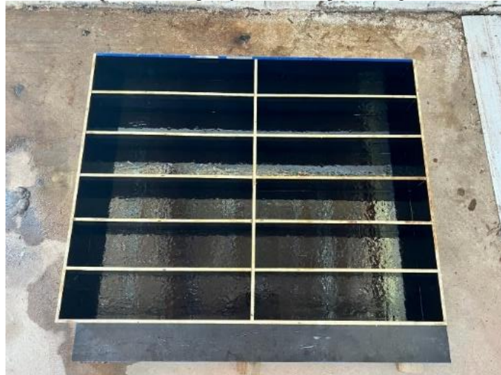
Figura 21 – Preparação da forma para as vigas.
