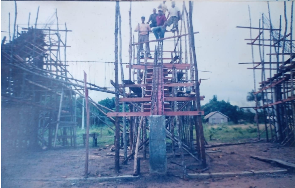
Figura 68 - Imagem do início da construção do Tribódromo
