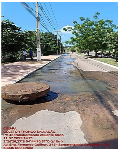
Figura 17: Transbordo de esgoto bruto no residencial Salvação
