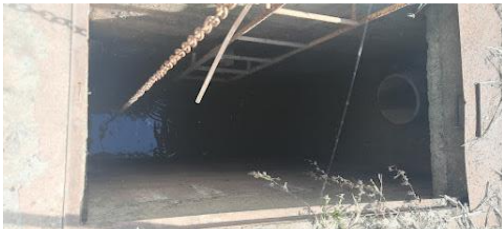
Figuras 21: Entrada do Esgoto
