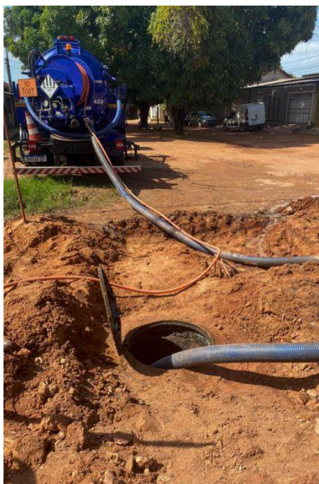
Figura 6: Limpeza do esgoto no bairro do Jardim Santarém
