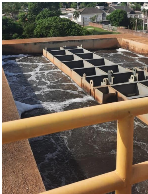
Figura 30: Reator aeróbio U-Box
