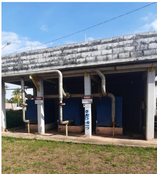
Figura 37: Sopradores de ar tipos “roots”
