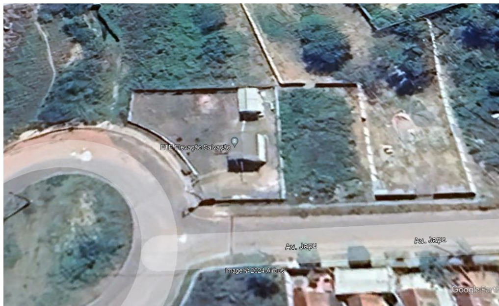
Figura 16: Estação Elevada de Esgotamento do Residencial Salvação
