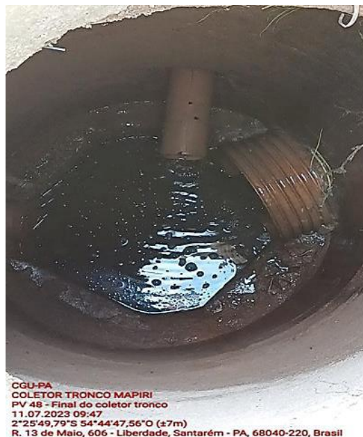
Figura 10: Ligação normal. Rede coletora.
