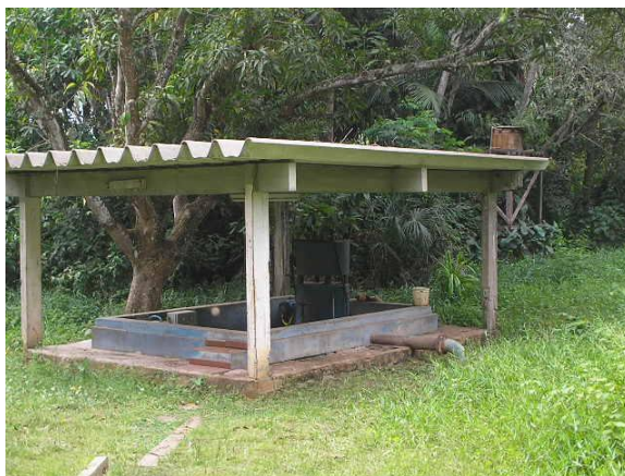
Figura 4: Complexo produtor Caranazal – Sistema de ponteiras
