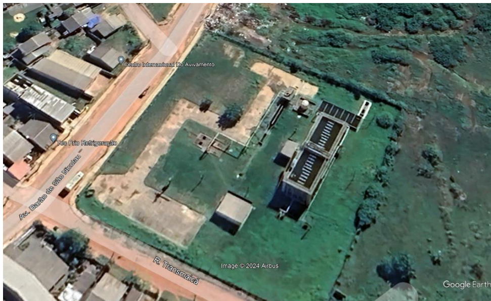
Figura 15: Estação de Tratamento do Uruará
