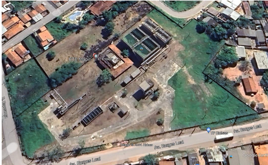
Figura 14: Estação de Tratamento do Esgoto Mapiri
