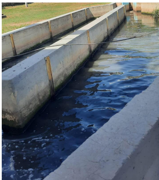
Figura 25: Desarenador/caixa de areia
