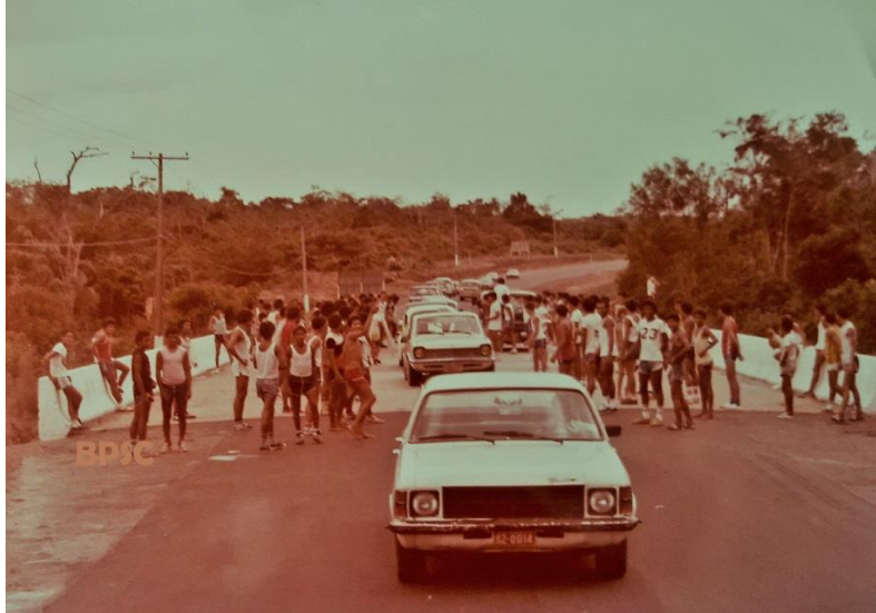
Figura 9 – Ponte do Juá – Avenida Fernando Guilhon- 1980
