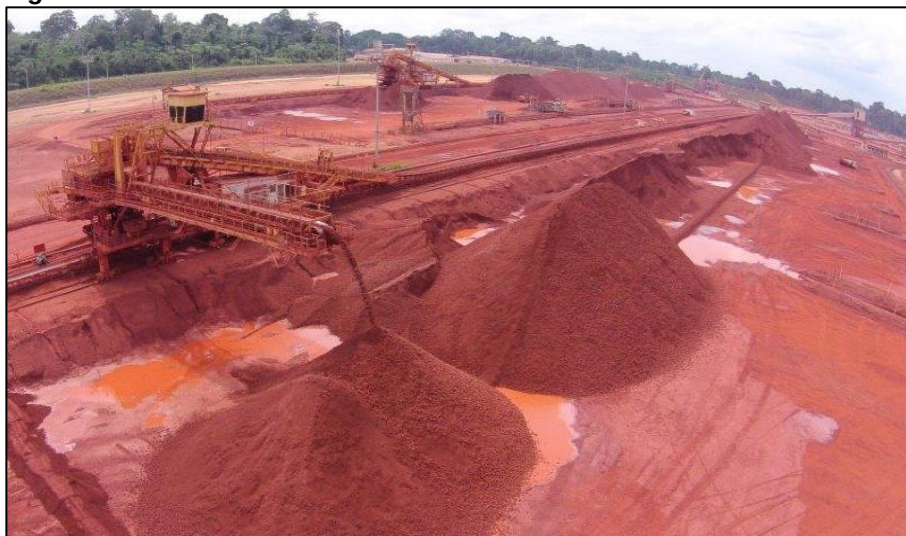
Figura 17 - Pilhas de minério lavado do beneficiamento de Juruti
