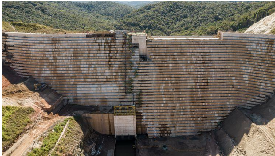
Figura 1 – Muro de CONTENÇÃO
