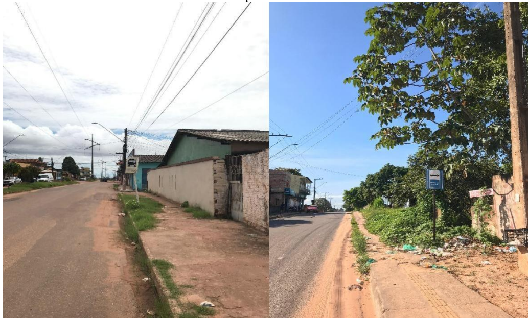
Imagem 1 – Pontos de ônibus sem infraestrutura adequada.
