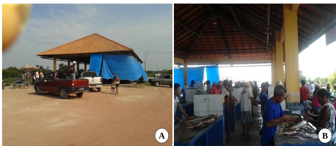
Figura 6. Foto da área externa do Mercado do Porto dos Milagres – A; Foto da área interna do Mercado do Porto dos Milagres, após o PAC.
