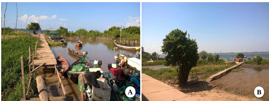
Figura 13. Ponte já em construção próximo ao mercado - A; Ponte já construída e o espaço já todo seco.
