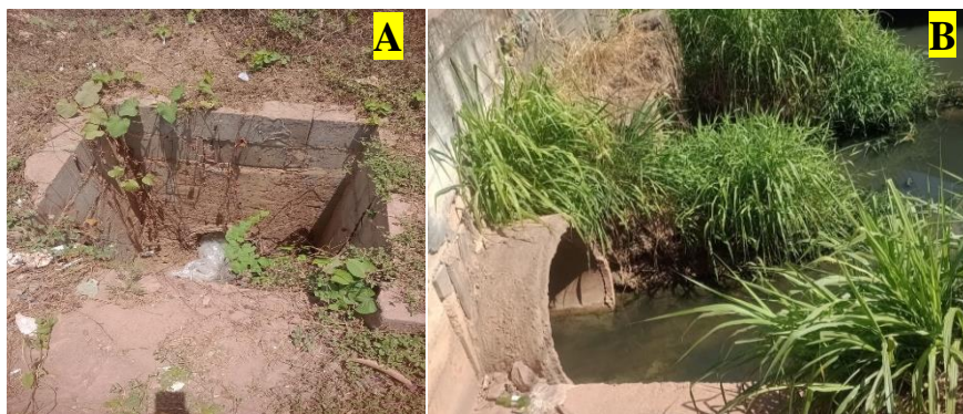
Figura 13 – Registros fotográficos no cruzamento da Rodovia Transamazônica com o Igarapé Oriundo em agosto de 2024: A) vista superior de galeria de microdrenagem em PI-3; e B) dispositivos de transposição do canal em PI-4.
