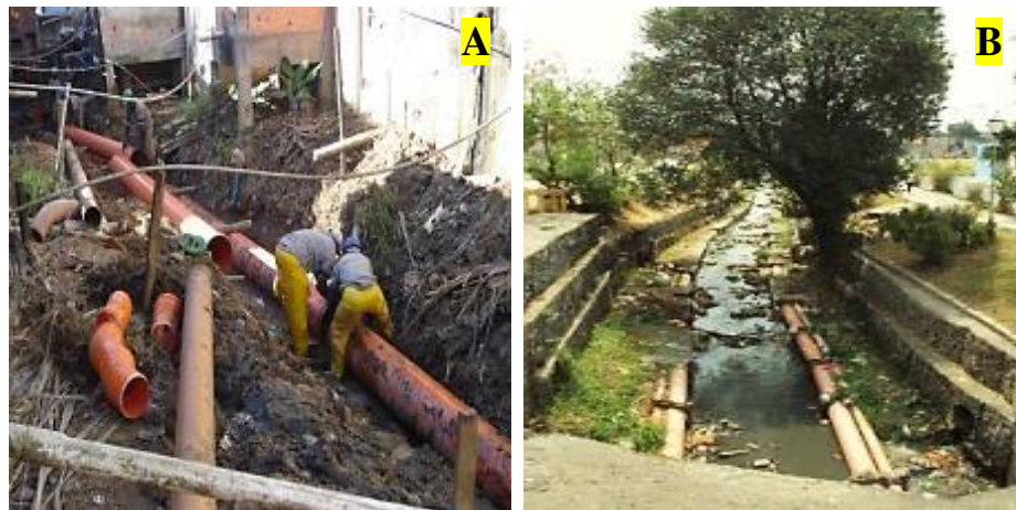
Figura 22 – Projeto de Revitalização de Córregos em Guarulhos – SP: A) Colocação de canos de PVC para separação das águas residuais; e B) demonstração do sistema de separação com os condutos fechados para águas residuais e o canal aberto para águas pluviais.
