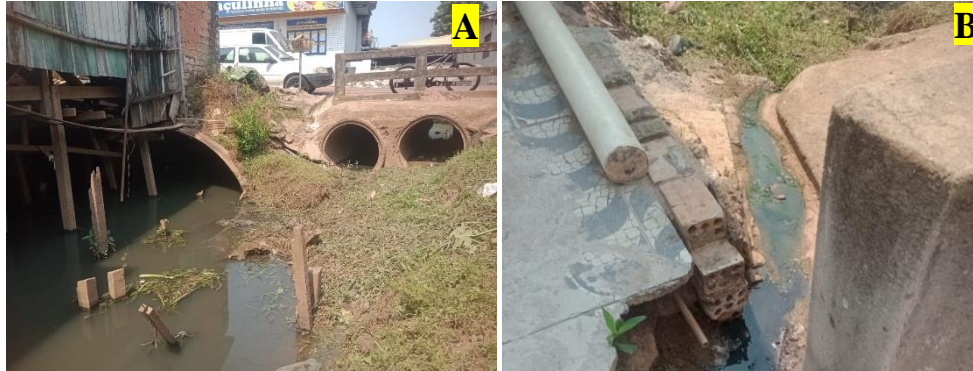
Figura 14 – Registros fotográficos no ponto de interesse no PI-5 em setembro de 2024: A) Dispositivos de macrodrenagem para transposição do canal pela via; e B) canaletas com lançamento direto no canal.
