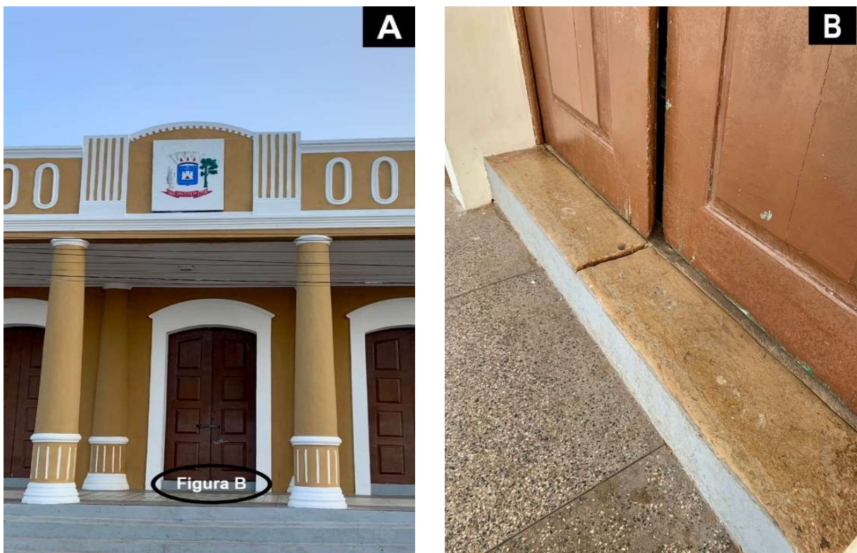
Figura 9 - Uso do Calcário de Lioz. (A) Centro Cultural João Fona. (B) Batente da porta principal revestido com Calcário de Lioz.
