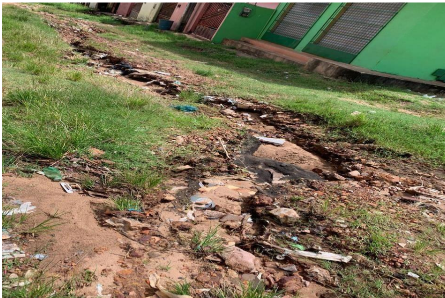
Figura 14 – Problema de erosão do solo.
