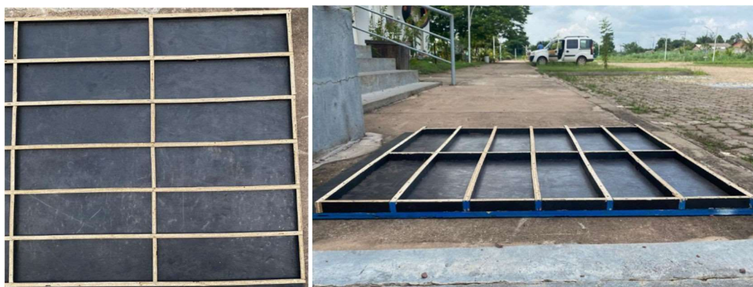
Figura 20 - Preparação das formas das placas pré-moldadas.
