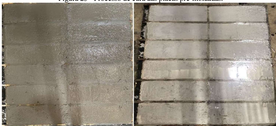
Figura 23 - Processo de cura das placas pré-moldadas.
