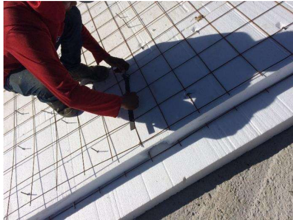
Figura 11 - Fabricação da Parede Monolítica no local
