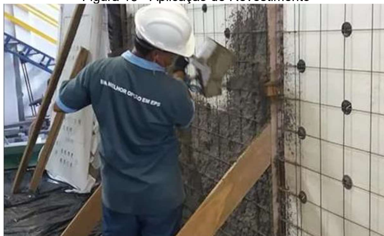
Figura 18 - Aplicação de Revestimento
