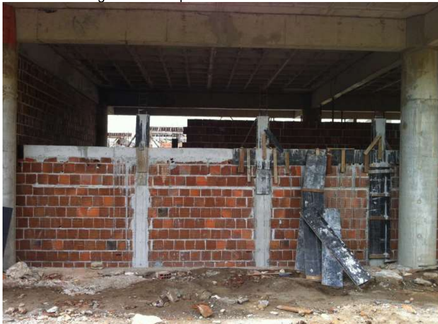
Figura 19 - Desperdício em canteiro de obras
