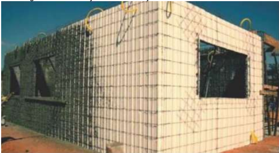
Figura 20 - Construção com a utilização de Painel Monolítico em EPS
