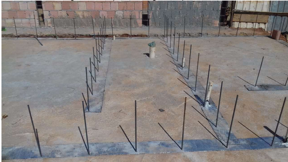
Figura 15 - Espera de vergalhões posicionadas
