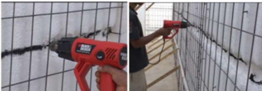
Figura 16 - Abertura para instalações com soprador térmico
