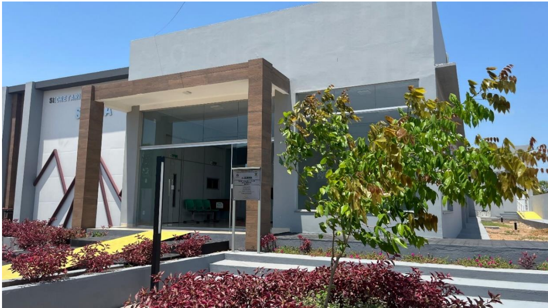
Figura 2 – Imagem do prédio da Semma construído com o recurso do ICMS Verde
