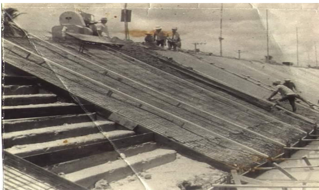
Figura 5: Registro da construção do cais de arrimo, 1977. Fonte: http://4.bp.blogspot.com
