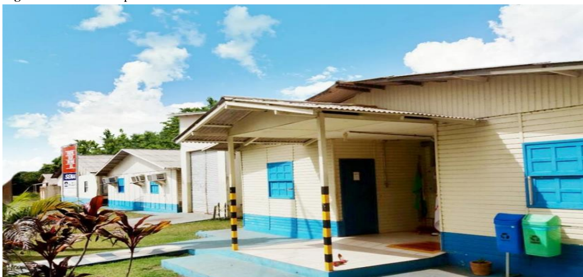
Figura 5 - Fachada do prédio do SENAI em Juruti.
