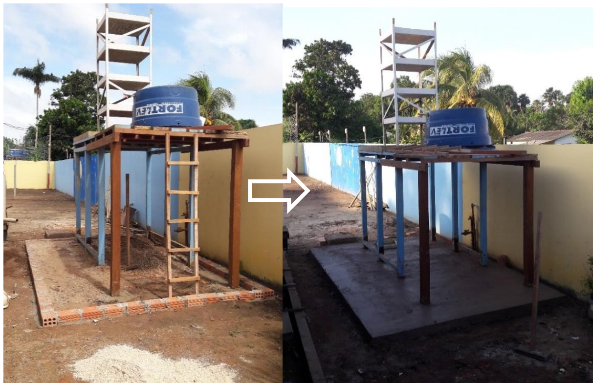
Figura 22 - Construção da base em concreto. Fonte: Direta.
