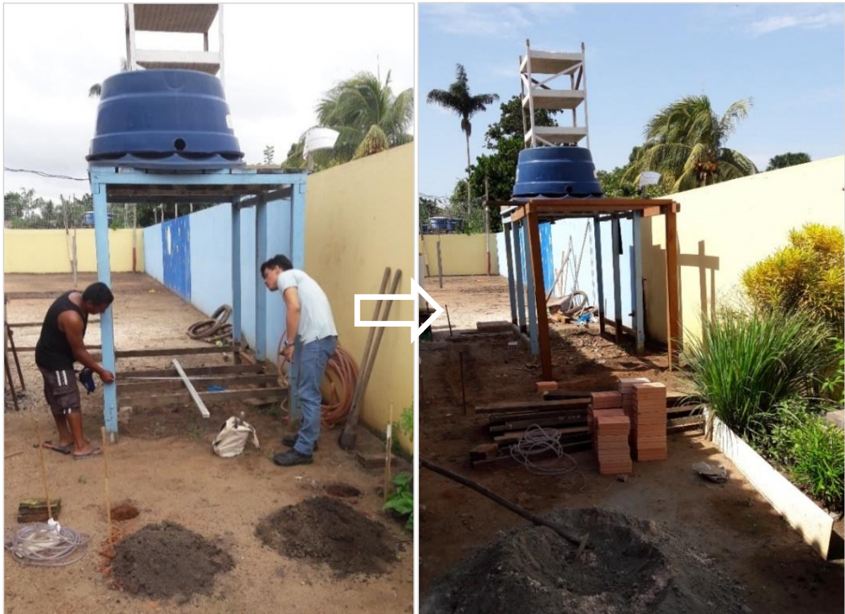
Figura 21 - Preparação para construção da base em concreto. Fonte: Direta.
