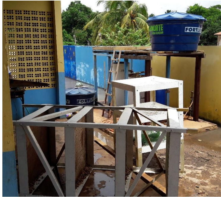
Figura 24 - Adaptação da unidade de aeração Fonte: Direta.
