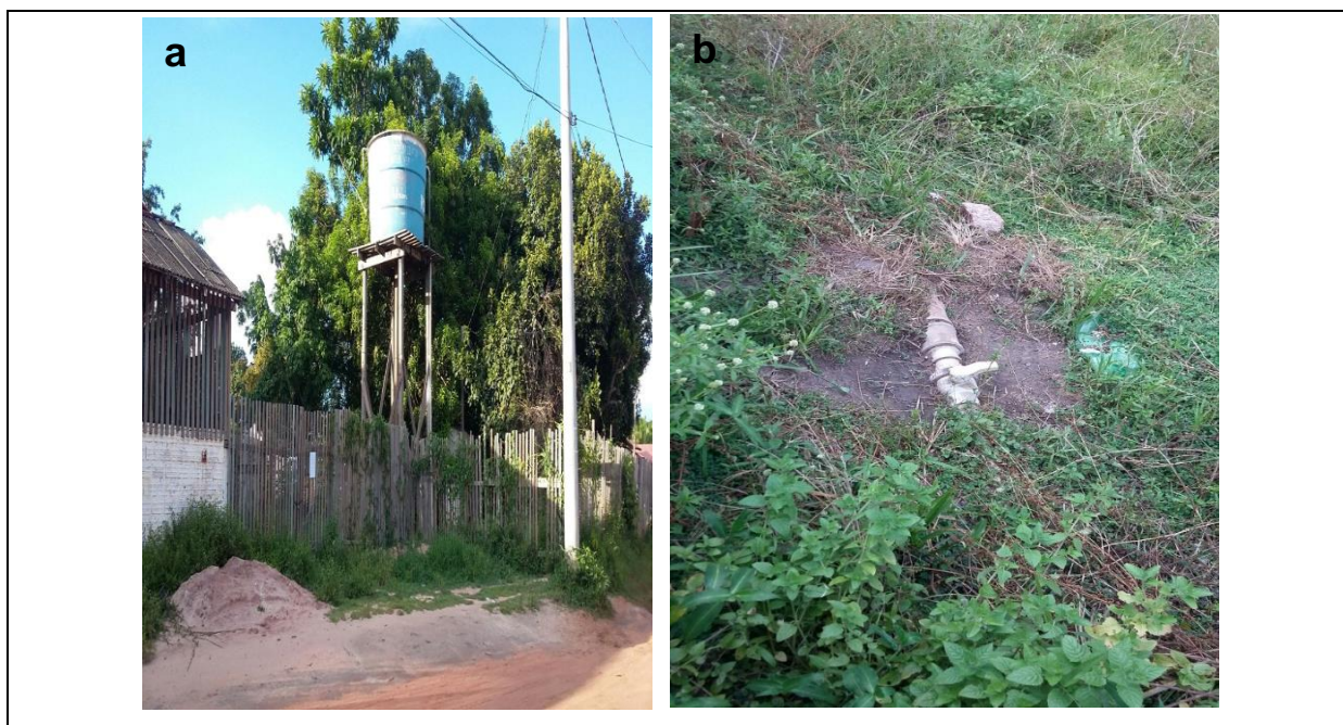
Figura 3 – a) Reservatório Elevado. b) Sistema de Distribuição. Fonte: Os autores, 2017.
