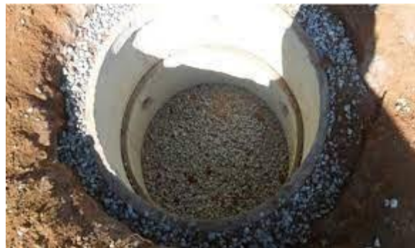
Figura 7 - Poço de infiltração com concreto furado.
