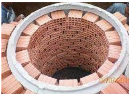
Figura 5 - Poço de infiltração com tijolos.
