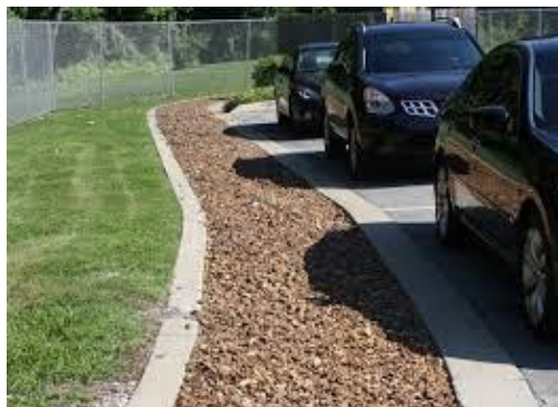
Figura 10 - Trincheira de infiltração para drenagem de águas pluviais
