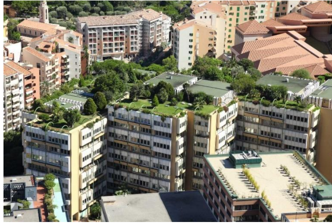
Figura 2 - Telhados verdes instalados em edifícios.
