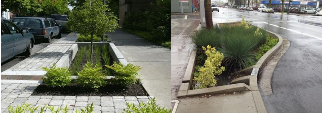
Figura 8- Jardim de chuva para drenagem de águas pluviais
