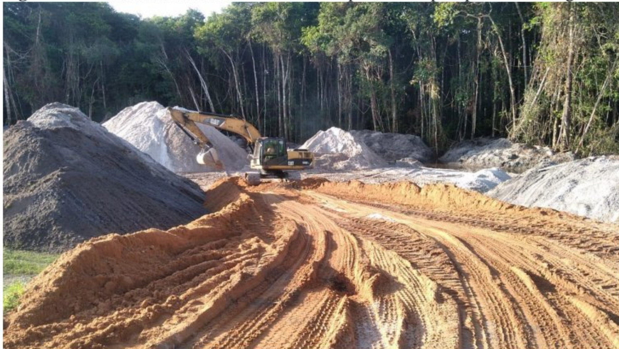
Figura 13 - Escavadeira hidráulica realizando empilhamento para posterior carregamento.
