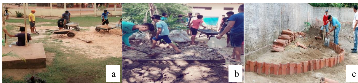
Figura 6. Limpeza de ambientes da área Escolar: a, b: limpeza; c: construção de canteiro.
