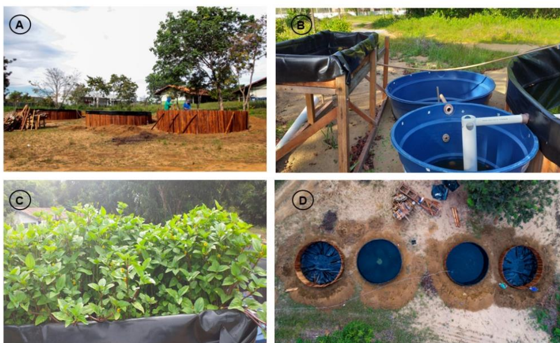
Figura 6 – a) fase inicial de construção dos tanques; b) implantação da caixa de jambu, decantador e filtro biológico; c) mudas de jambu introduzidas nas caixas hidropônicas; d) vista área dos tanques.
