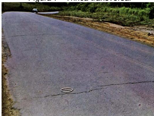
Figura 7 - Trinca transversal
