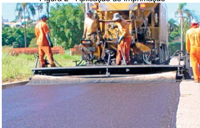
Figura 2 - Aplicação de Imprimação
