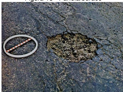
Figura 18 - Panela/buraco
