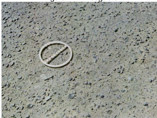
Figura 17 - Desgaste
