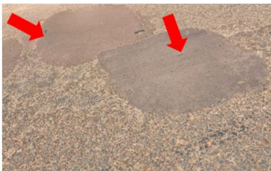
Figura 37 - Remendo profundo
