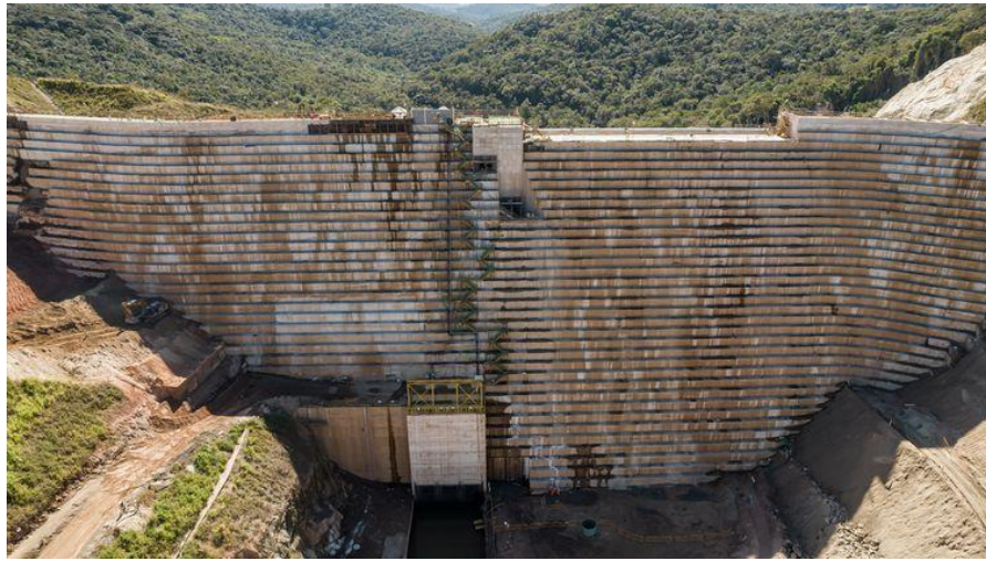
Figura 1 – Muro de Contenção
